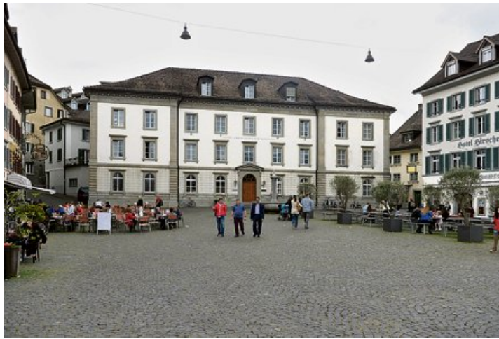
Verschlechtert: Alters- und Pflegeheim Bürgerspital Rapperswil. Foto: M. Matt
