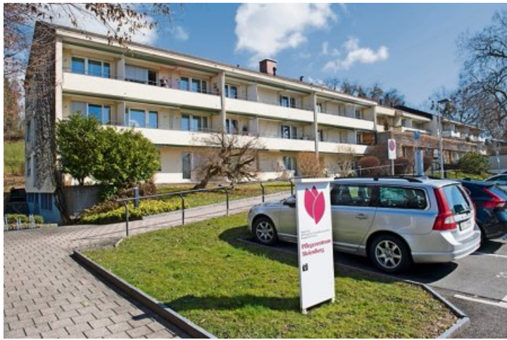
Verschlechtert: Pflegezentrum Meienberg in Rapperswil-Jona. Foto: Michael Trost
